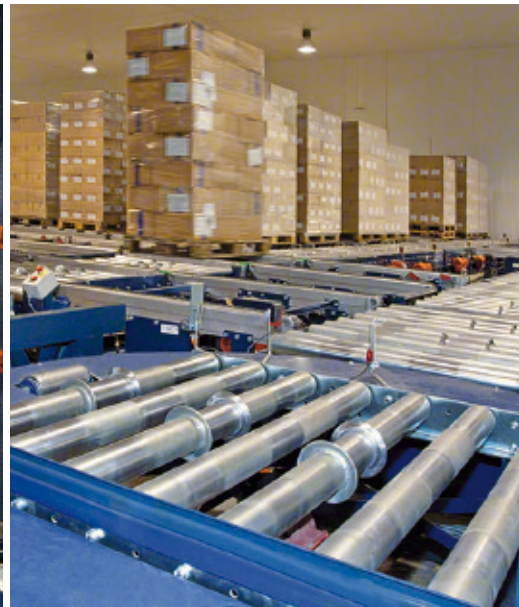
Transportadores de zona de precarga.
