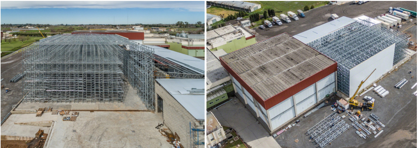
Almacén autoportante con cámara para producto congelado.
