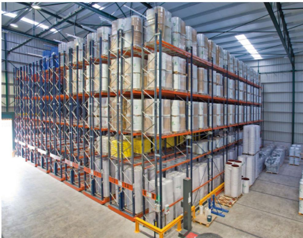
La utilización de estanterías con bases móviles Movirack proporciona la máxima optimización de la instalación
