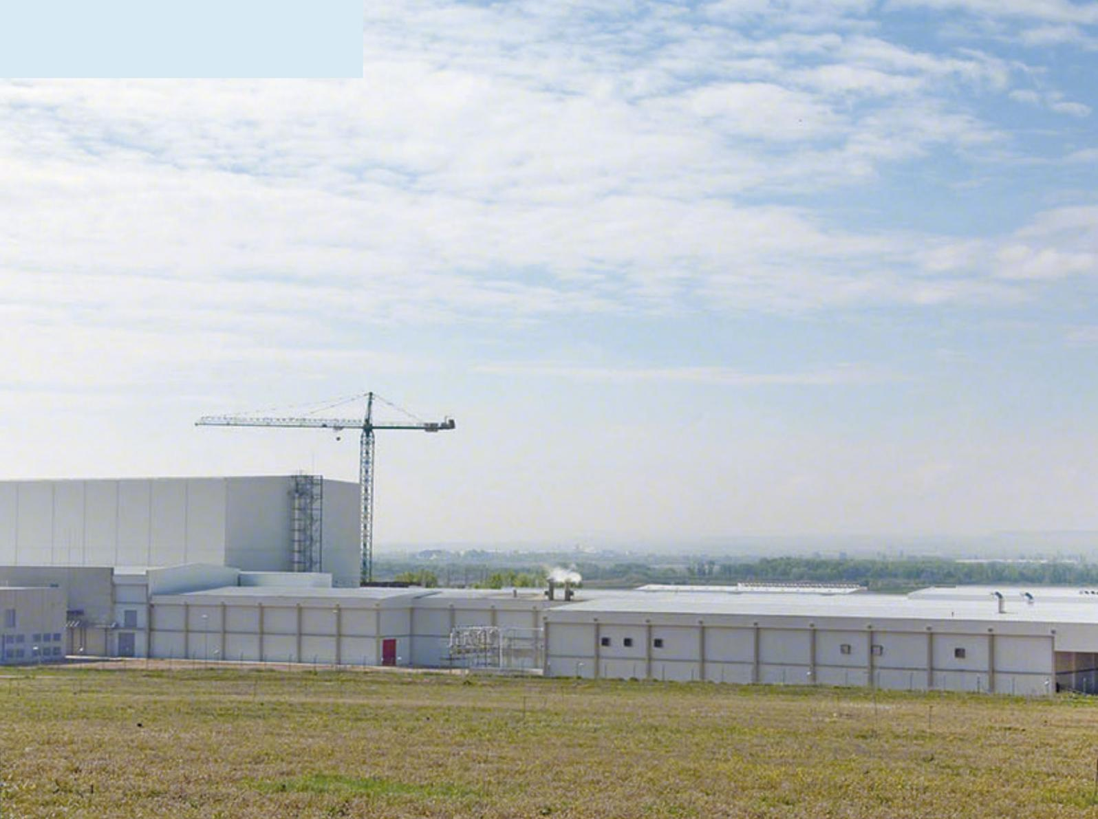
La construcción es muy simple. Sobre una losa de hormigón con resistencia y aislamiento adecuados anclamos y nivelamos los pies de las estanterías. La estructura se va conformando gracias a módulos premontados de altura y resistencia variables. Sobre la estructura se colocan las cerchas y correas de cubierta además de los perfiles de fachada, a los que se fijan los paneles aislantes.
